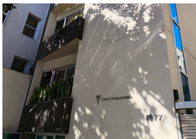
Fachada da sede da FMF
